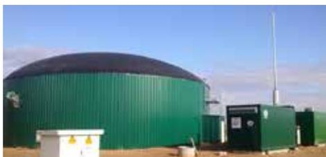
Foto 13. Digestores en una planta de producción de biogás
