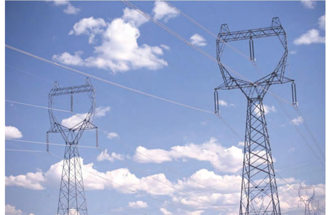
Para transmitir la energía eléctrica se utilizan **líneas de transmisión de energía eléctrica** que conectan las diferentes instalaciones. Estas líneas de transmisión pueden ser **aéreas**, con los conductores instalados sobre apoyos, o subterráneas, con los conductores instalados en zanjas y galerías.
